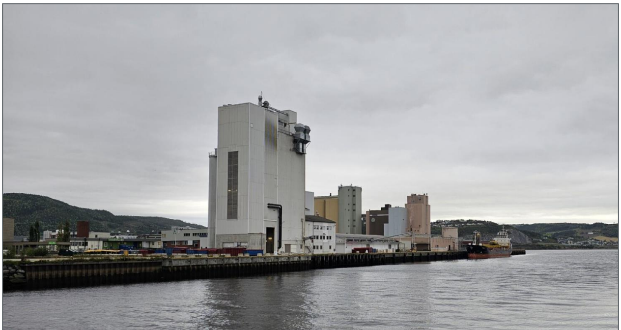
Figur 2-7: Kaianlegget og kornsiloen sett fra nord
