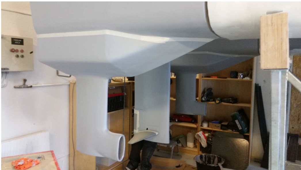
Figur 98: 14. Mai 2019 - Maskinrom er ferdigmontert
