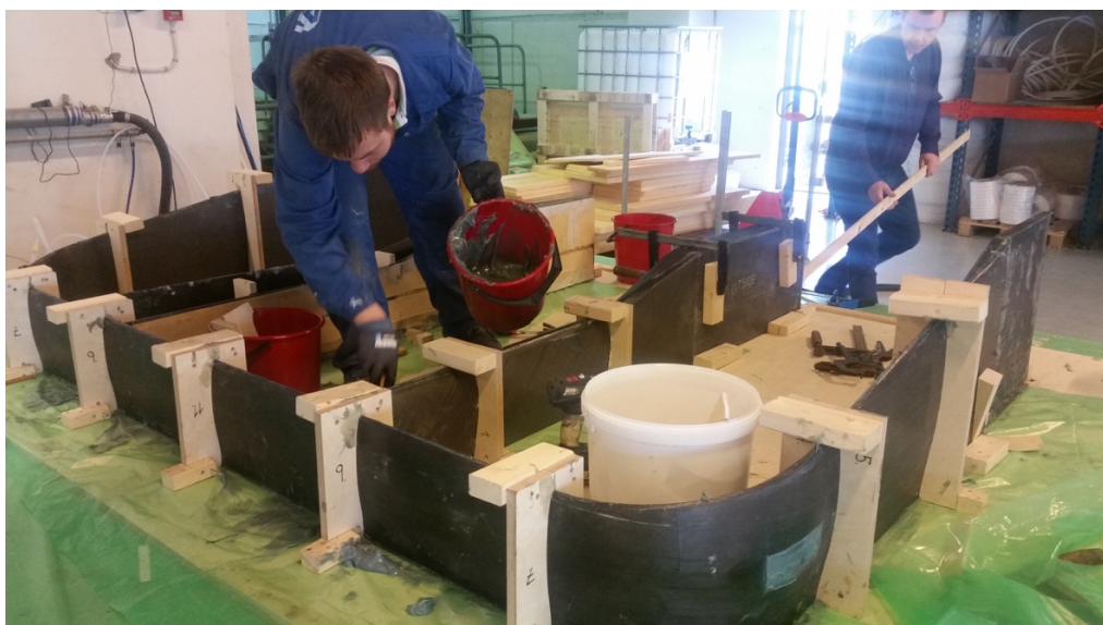
Figur 90: 1. Mars 2019 - Midtstøtter og hovedvinge støpes sammen
